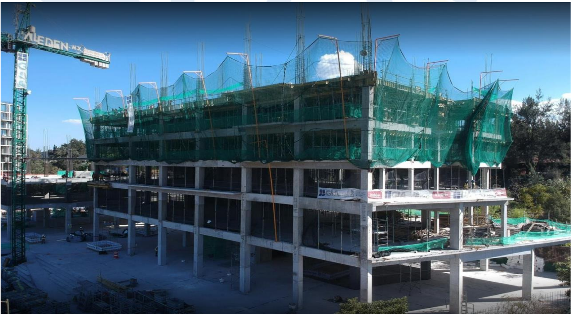
OBRA PUERTA ALEDEN EN PROCESO
