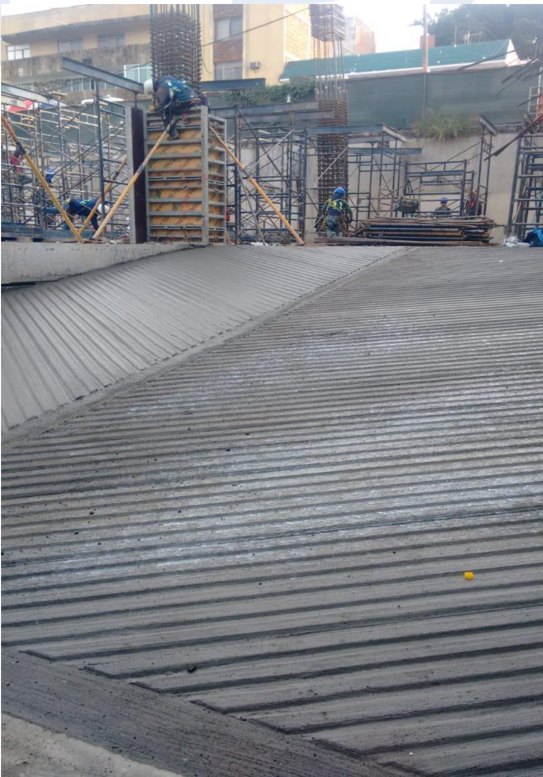
RAMPA TERMINADO ESTRIADO
