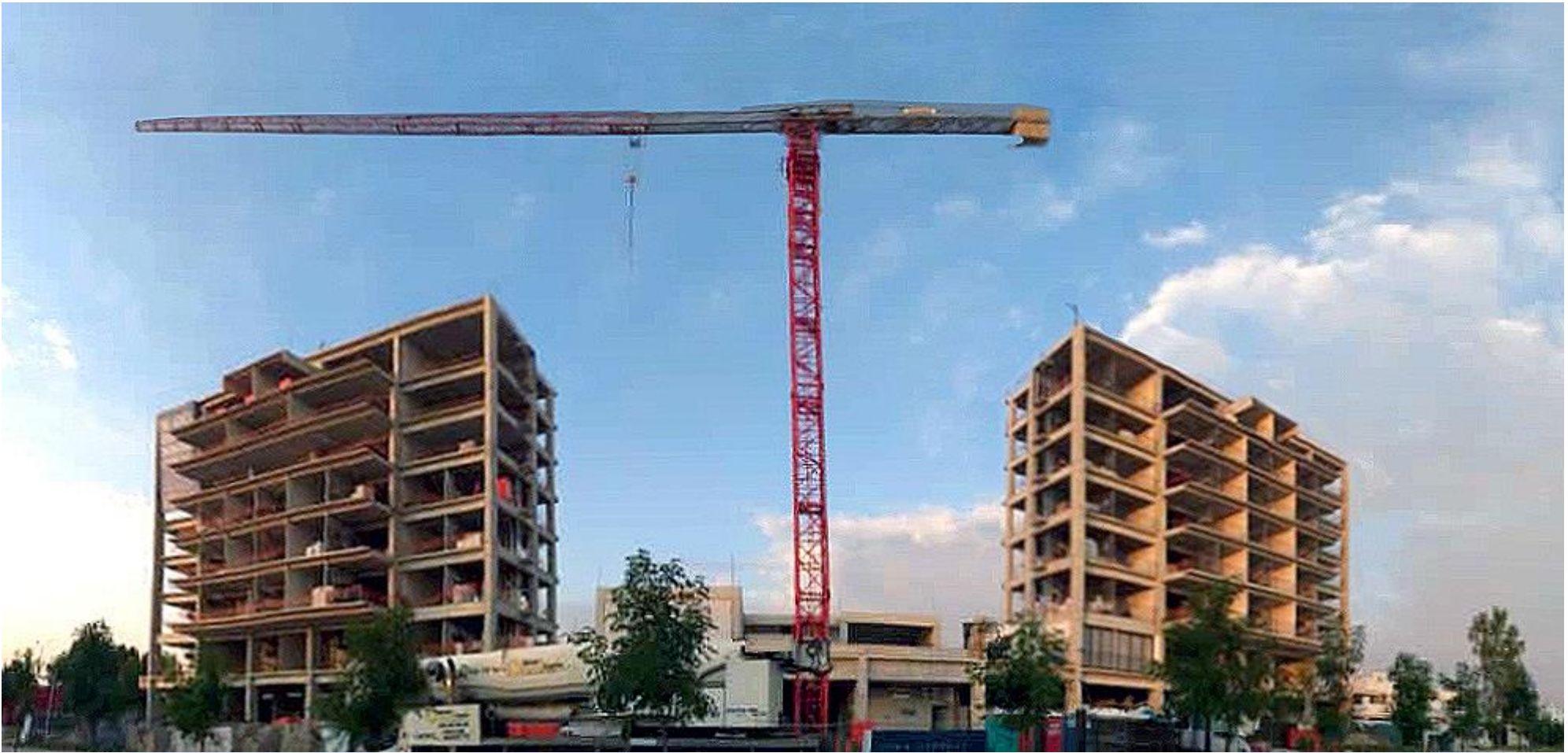
OBRA ESTRELA LIVING EN PROCESO
