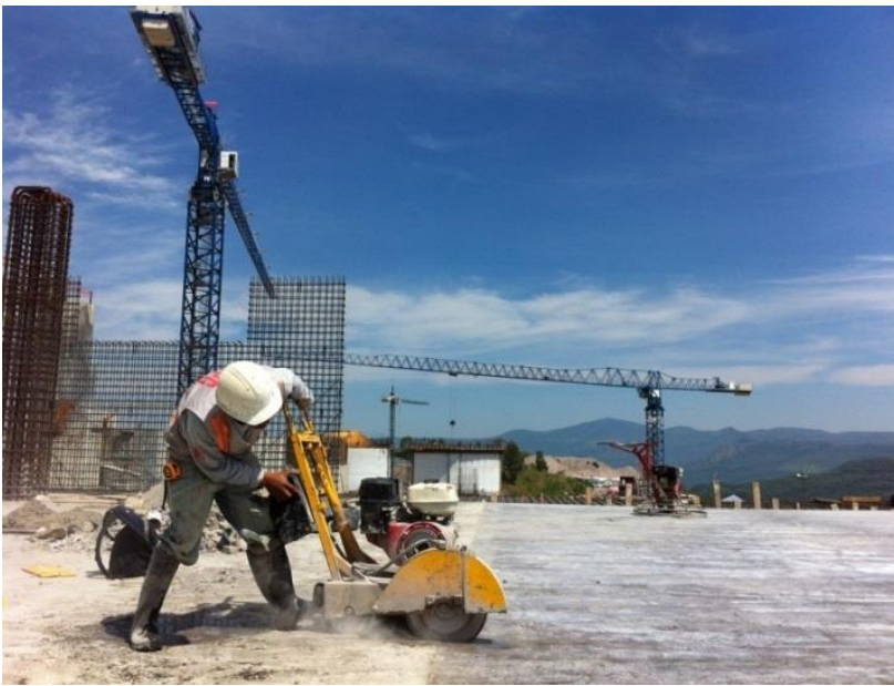
PTAR AGUAPRIETA (ICA)
