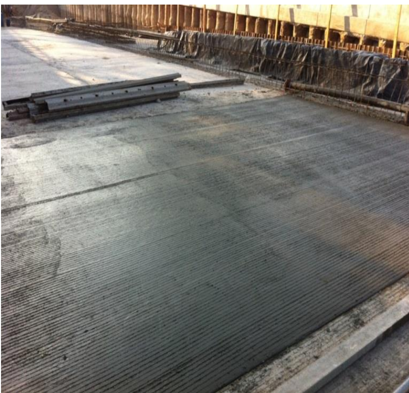
PASO DESNIVEL AVENIDA VALLARTA (GAL-GAR CONSTRUCCIONES)
